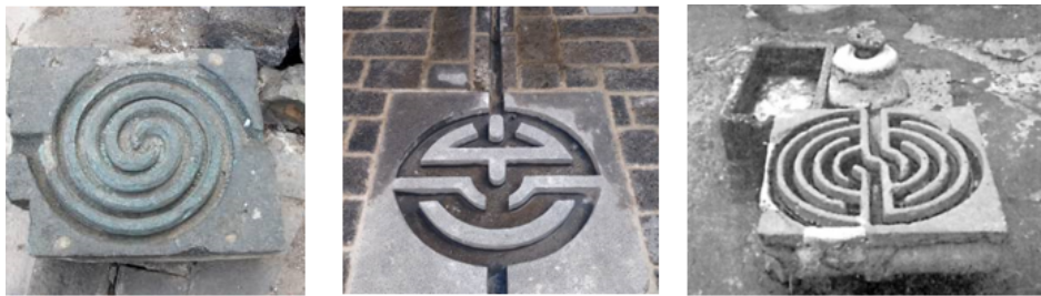
Fotoğraf-24. Diyarbakır Havuzlarında Su Boşaltma Hazneleri
